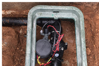
2. ติดตั้งชุดวาล์วระบายน้ำอัตโนมัติ
